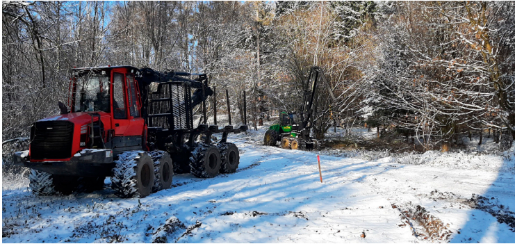
Die Vorbereitungsarbeiten für die Windräder in Böheimkirchen wurden abgeschlossen.
